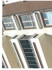
Окраска по штукатурке
